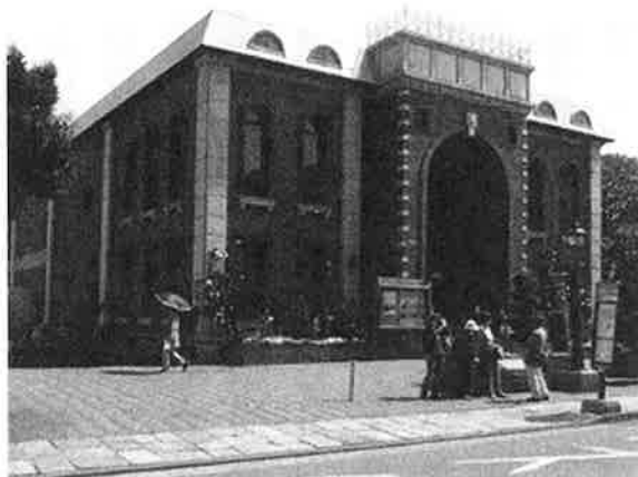
写真6 ゲーテ座劇場（1885年に建立）。 現建物は1980年に岩崎博物館として建設。
