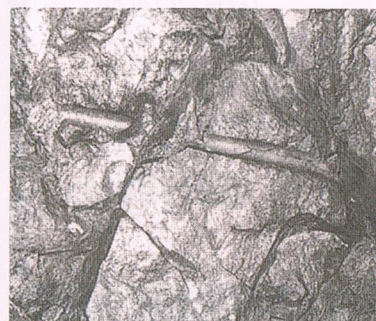
岩に残る削岩用ロッド跡
